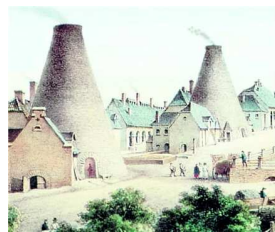
Die Glashütte Schauenstein in der zweiten Hälfte des 19. Jahrhunderts.
